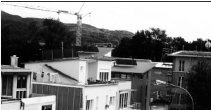
Solaranlagen im Quartier Vauban: kleine Photovoltaikanlage (ganz oben) und thermische Solaranlage (oben links) auf dem Dach der Baugruppe 14, Photovoltaikanlage auf der Quartiersgarage (oben) und Blick über die Dächer verschiedener Baugruppen und Einzelbauleute (links).
