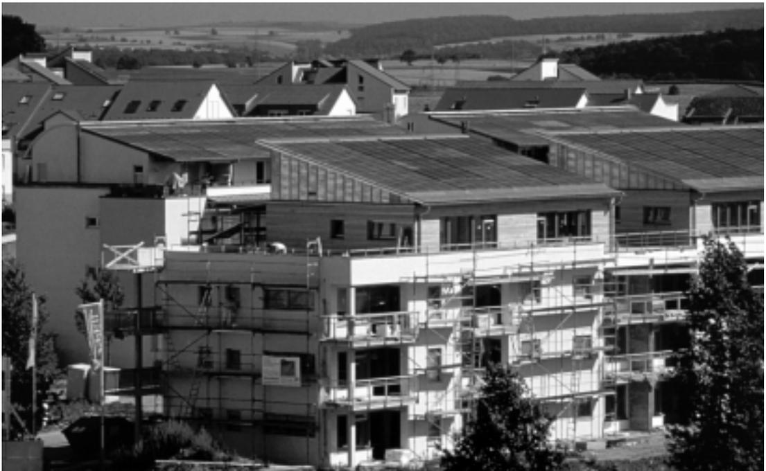
Im Stadtteil Amorbach in Neckarsulm entsteht ein solares Nahwärmesystem mit Langzeitspeicher, das im Endausbau 1.300 Wohneinheiten versorgen wird. Das Foto zeigt die mit Sonnenkollektoren ausgerüsteten Neubauten.
