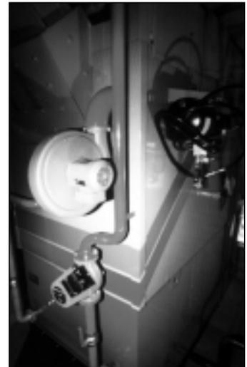
Feuerungskessel des Hackschnitzelheizwerks der Biowärme Vrees GmbH.
